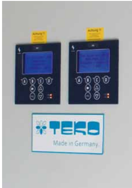
Bei der Regeltechnik wird auf das „Frigolink“-System von Wurm gesetzt.
