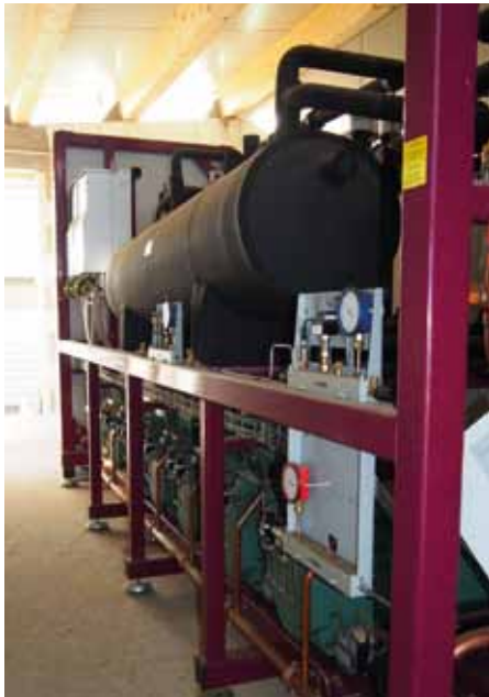
„ROXSTAindustrial“-Kältemaschine in der Kältezentrale
