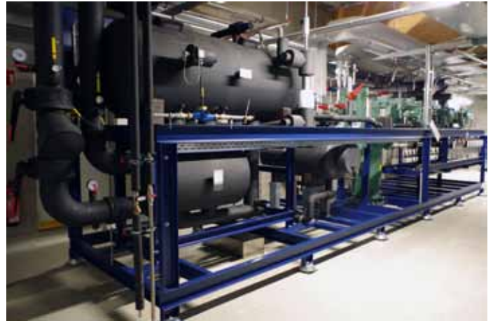
R717-Kaltsoleerzeuger mit der Abscheider-Verdampfer-Economiser-Sektion
