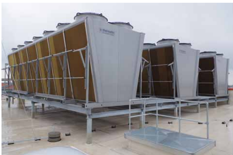
V-Verflüssiger für R717-Kaltsoleerzeuger
