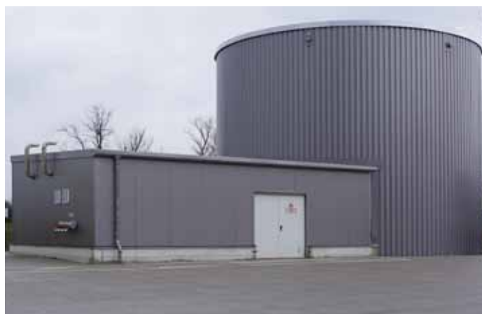
Sprinklerwassertank/Pufferspeicher für Wärmerückgewinnung
