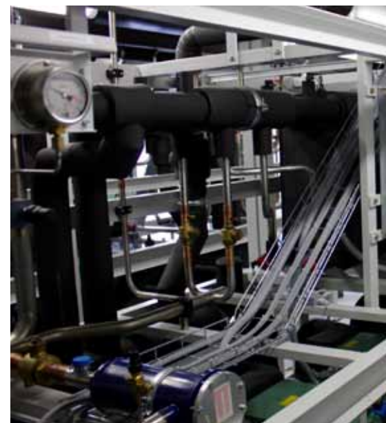
R134a-Stufe der Kältekaskade
