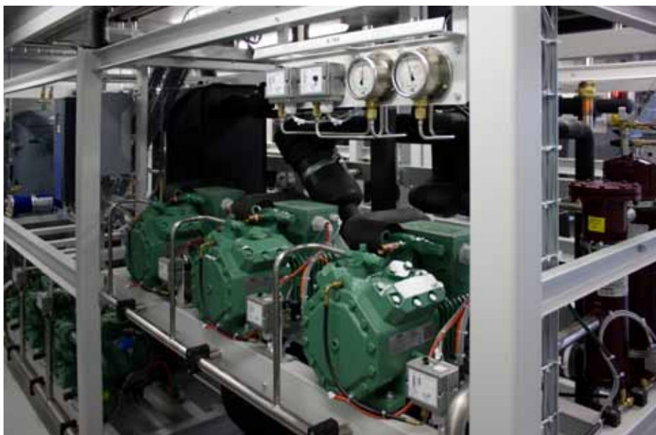
CO 2 -Stufe der Kältekaskade
