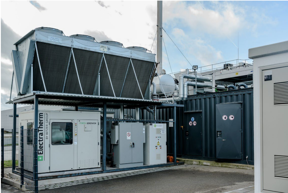
Bild 3: Der BITZER Standort in Rottenburg-Ergenzingen verfügt über eine ORC-Anlage (ORC = Organic Rankine Cycle), die aus normalerweise ungenutzter Abwärme Strom erzeugt
