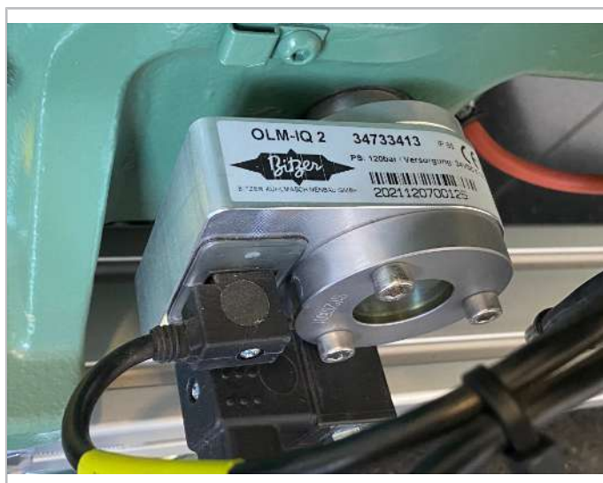
Fig. 14: Regulador del nivel de aceite OLM-IQ2 (número de la pieza 347 334 13) en el compresor (ejemplo)
