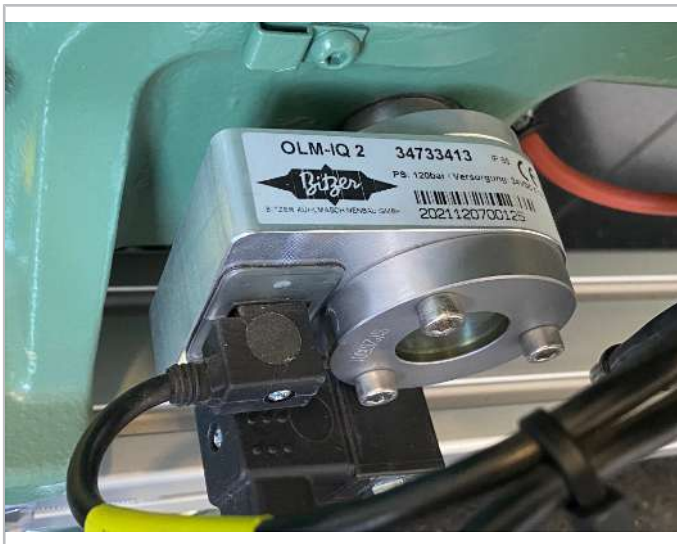
Abb. 14: Ölniveauregler OLM-IQ2 (Teilnr. 347 334 13) am Verdichter (Beispiel)
