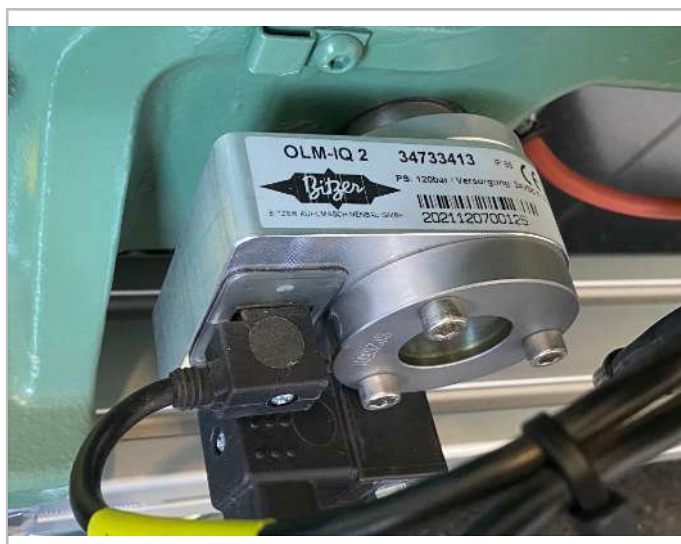
Fig. 14: Régulateur de niveau d'huile OLM-IQ2 (numéro de pièce 347 334 13) au compresseur (exemple)
