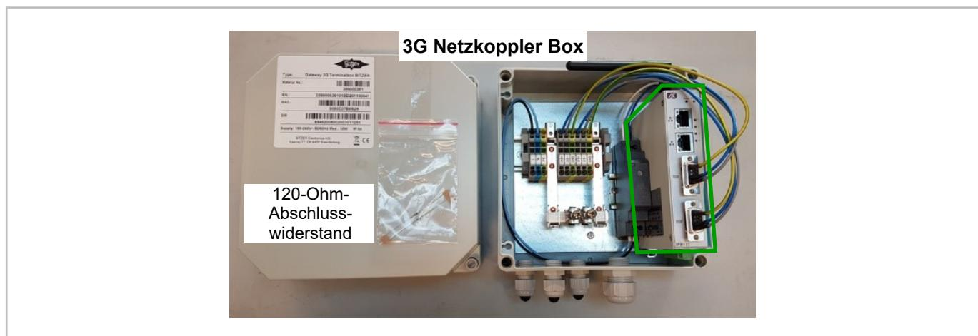
Abb. 1: Netzkoppler Box (Teilenummer 347 990 01) für die Montage mit BITZER Verflüssigungssätzen (Netzkoppler hier grün umrandet)
