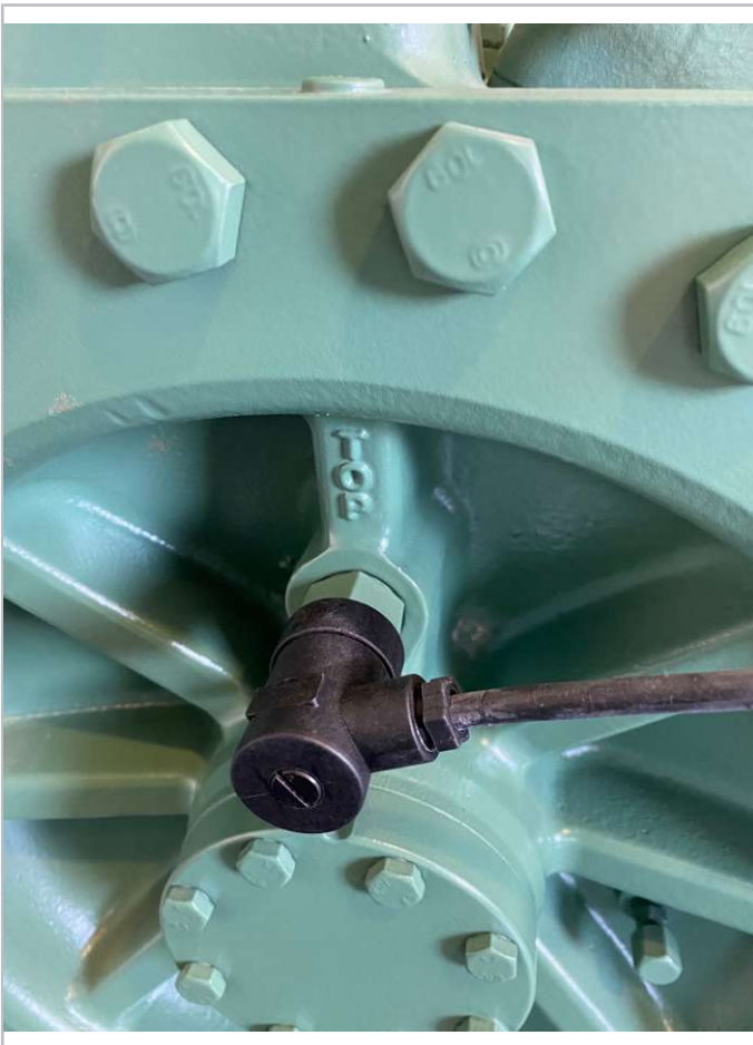
Abb. 40: Öldifferenzdruckschalter DP-1 am Verdichter (Beispielfoto)
