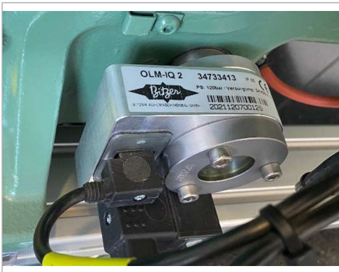
Abb. 44: Ölniveauregler OLM-IQ2 (Teilenr. 347 334 13) am Verdichter (Beispiel)
