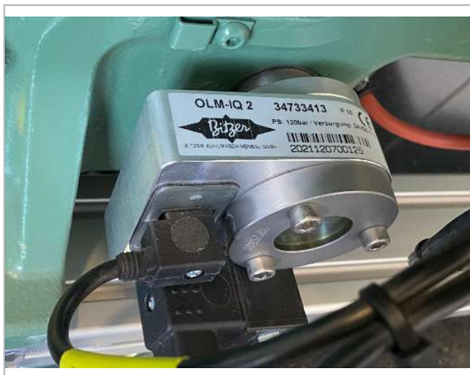
Рис. 13: Регулятор уровня масла OLM-IQ2 (арт. 347 334 13) на компрессоре (пример)
