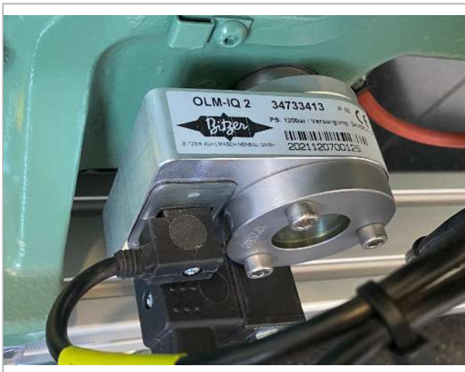
Fig. 13: Régulateur de niveau d'huile OLM-IQ2 (numéro de pièce 347 334 13) au compresseur (exemple)
